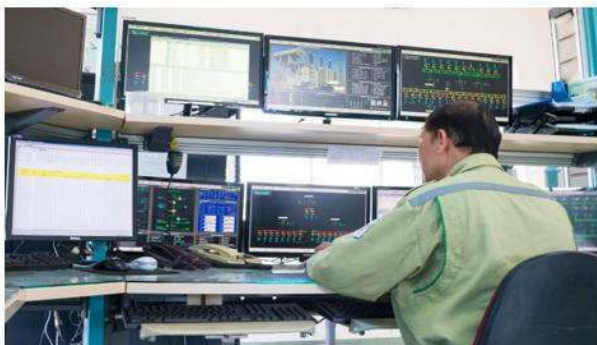
Hình 4 HTĐKTH tại TBA 220 kV [22]
